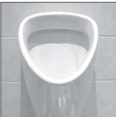
Keramik aufsetzen. Achtung - Kabel nicht einklemmen! Hauptwasserabsperrung öffnen, Strom einschalten - Betriebsbereit
