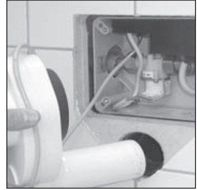
Sensorsiphon einstecken
