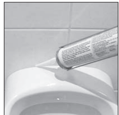
Wasserdichte Silikonverfugung rund um die Urinalkeramik herstellen
